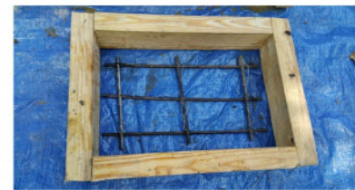
Cap rebar layout
